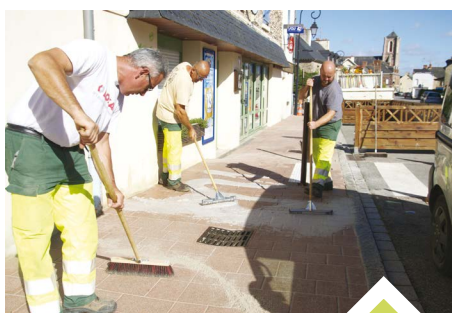
Réfection des joints de pavés à Pont-Réan
