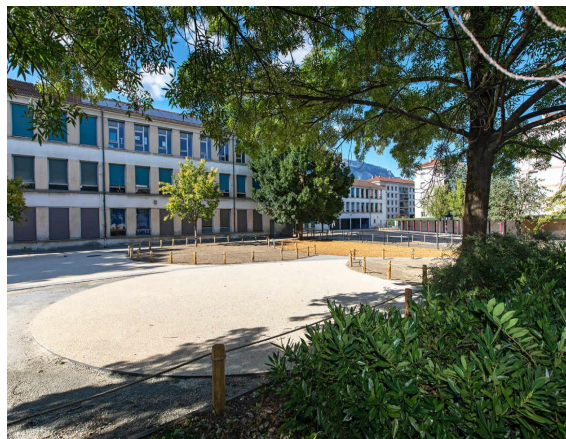
Ecole Clémenceau, Grenoble : bulle détente dans la cour > LIEN WEB
